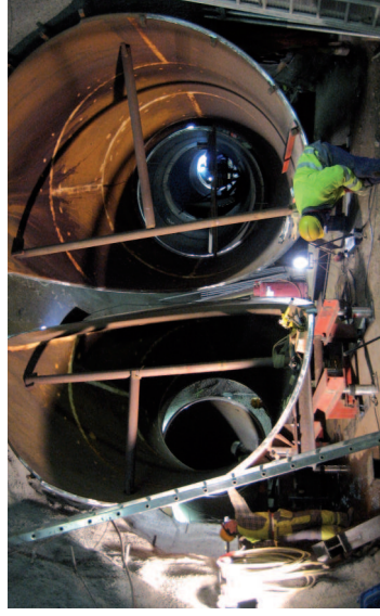
Photo 4 : Centrale hydroélectrique de Káhranjúkar en Islande. Soudage sur site d'une bifurcation S420, S460, S690 / Iceland Káhranjúkar hydroelectrical power plant. Site welding of a bifurcation, S420, S460, S690
